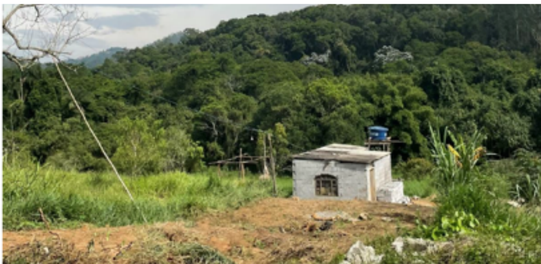
Figuras 11: Registro fotográfico de infrações – Ribeirão Pires
