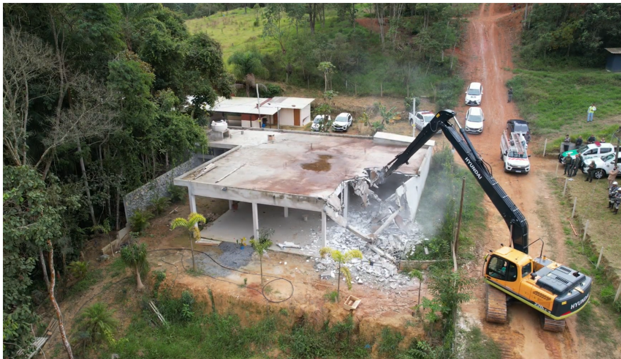
Figura 2 - Local da ação do dia 04/07/2025 no Município de Suzano
