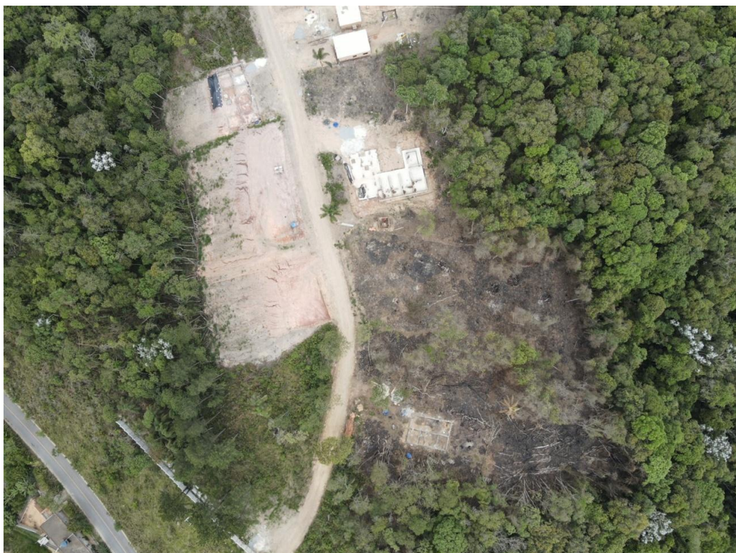
Figura 9 - Local da ação do dia 17/11/2025 no Município de Mairiporã - área 03
