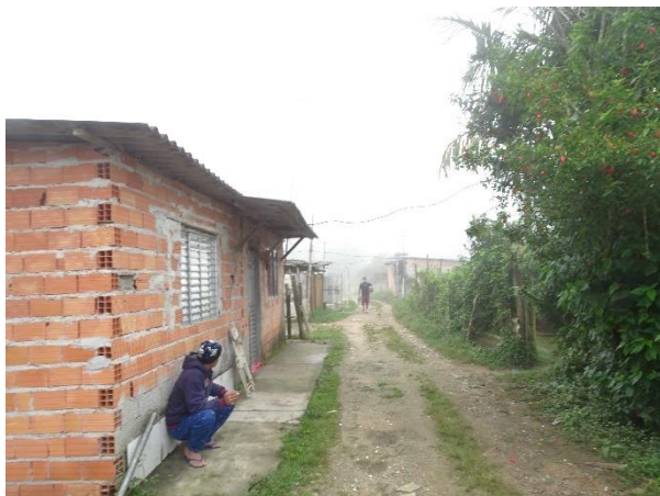
Figura 36: Construções irregulares habitadas
