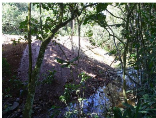
Figura 8: Movimentação de terra junto ao leito.
