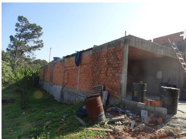
Figura 21: Construção não finalizada.
