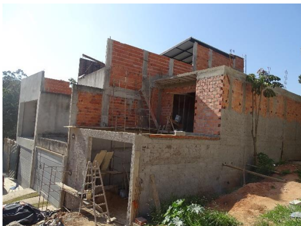
Figura 25: Construções não finalizadas.
