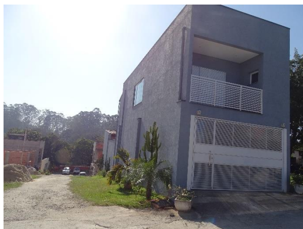
Figura 16: Construção padronizada finalizada.
