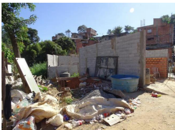
Figura 4: Construção irregular sobre o aterro.
