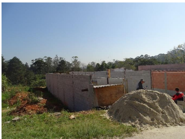
Figura 23: Construção não finalizada.
