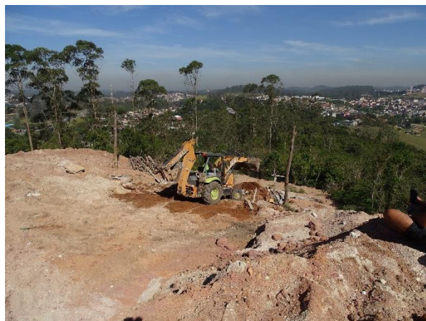
Figura 70: Desfazimento sobre aterro irregular.
