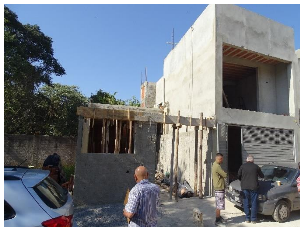
Figura 26: Construções em diversas fases.
