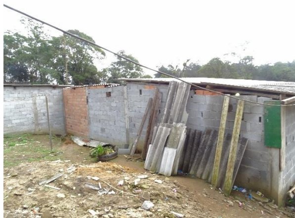
Figura 40: Construções irregulares habitadas
