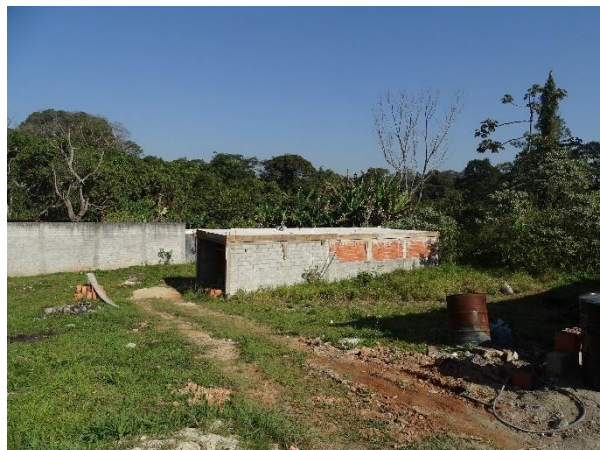
Figura 20: Construção não finalizada.
