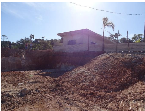
Figura 67: Movimentação de terra e construção.
