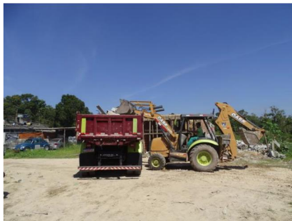
Figura 32: Retirada do entulho.
