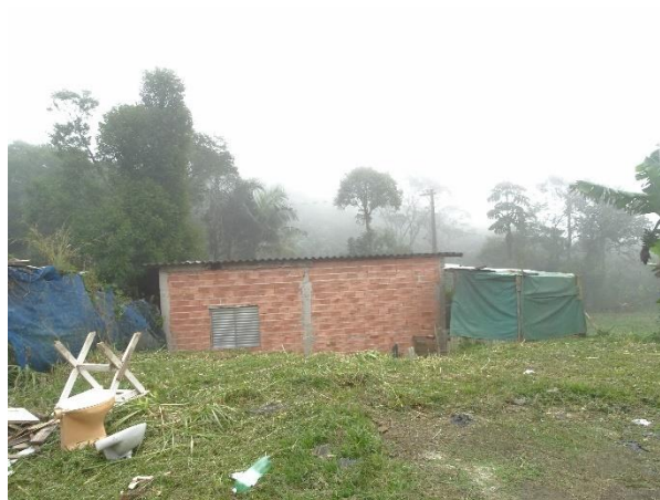
Figura 37: Construções irregulares habitadas
