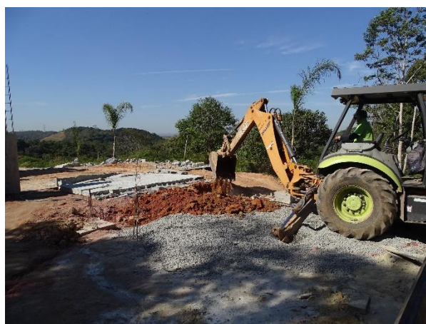
Figura 72: Desfazimento de muros externos.
