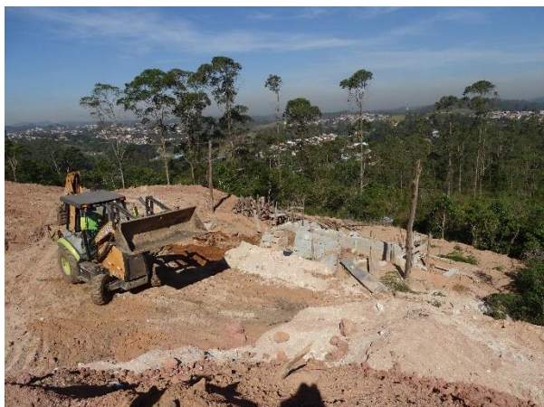
Figura 69: Desfazimento de construção secundária.
