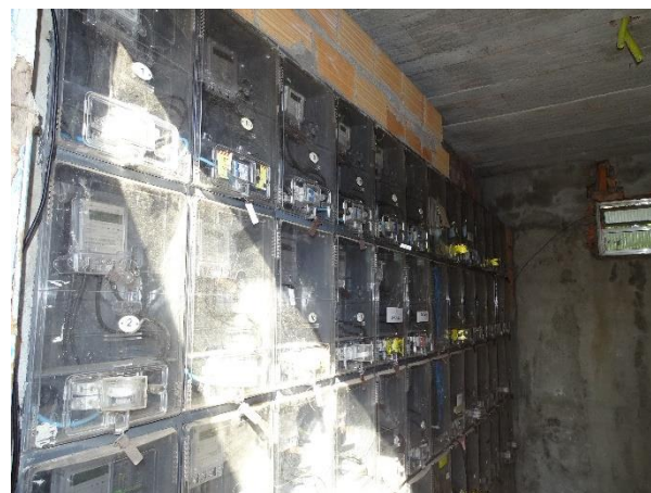
Figura 12: Quadros de energia individuais.
