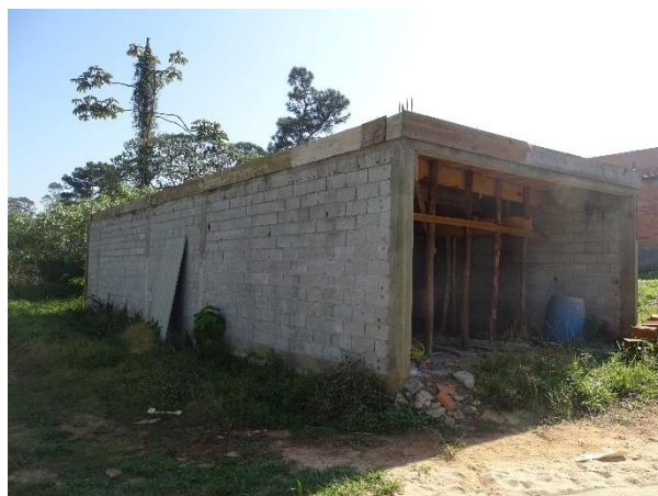
Figura 22: Construção não finalizada.
