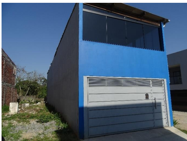
Figura 15: Construção padronizada finalizada.
