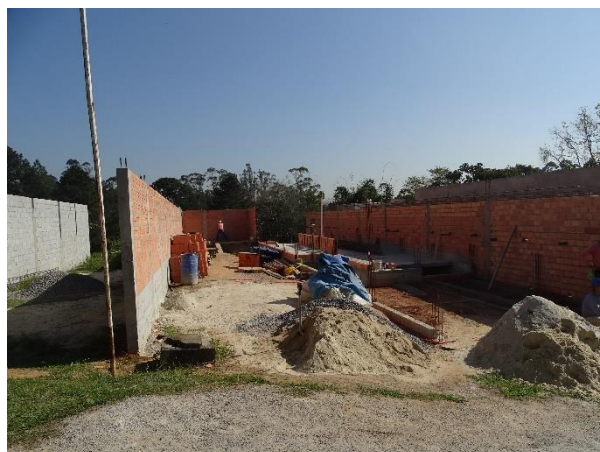
Figura 24: Construção não finalizada.
