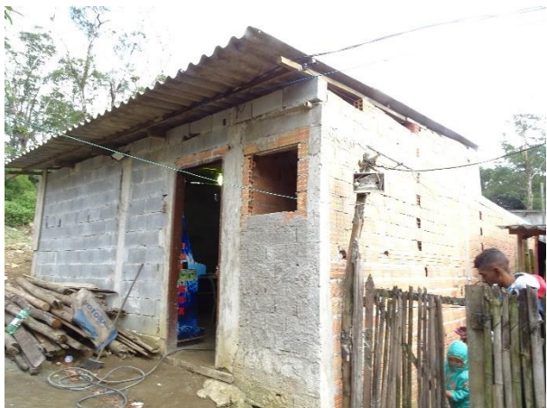
Figura 39: Construção irregular habitada
