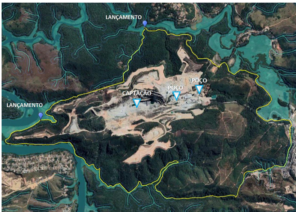
Figura 7 - Pontos de captação e lançamento de água.
