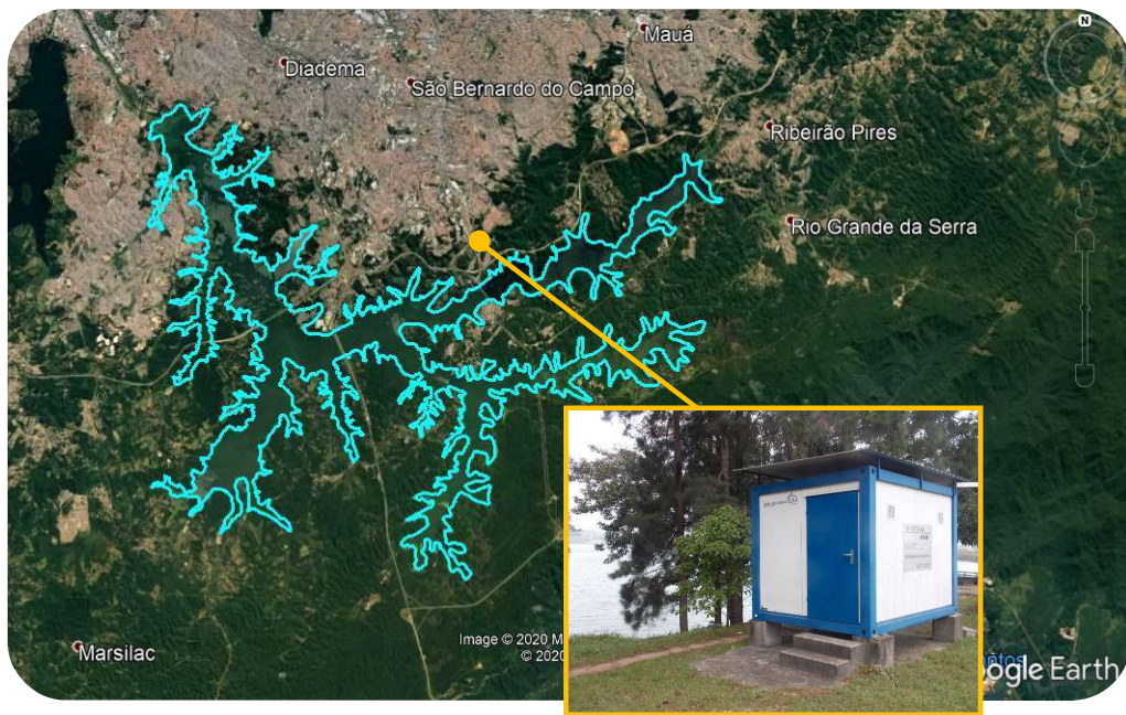
Estação Rio Grande
