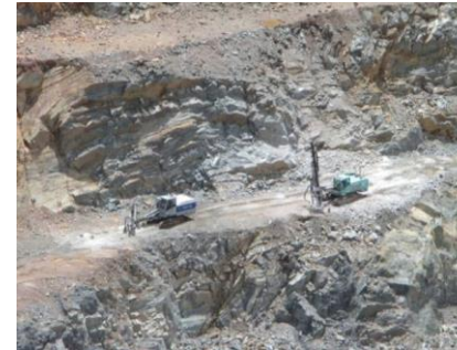
Perfuratrizes realizando os furos para preenchimento com explosivos
