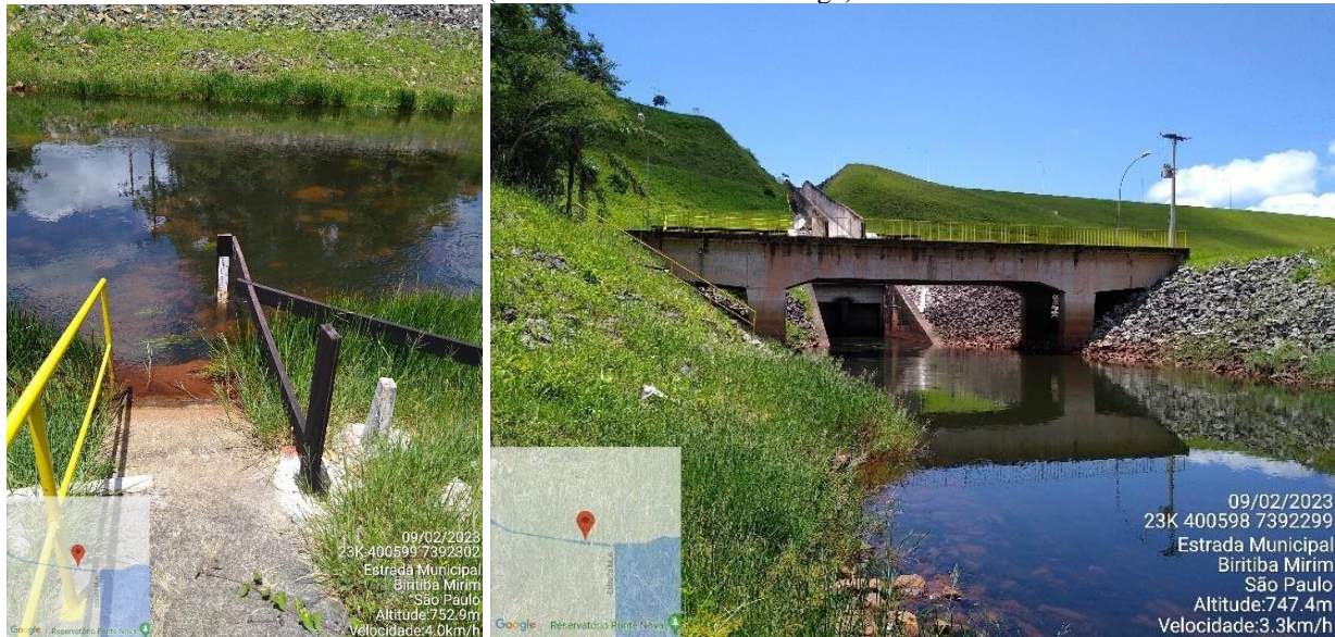
Figura 2 – Seção de controle entre os Subdistritos de Drenagem CBM-2 (Salesópolis-Rio Paraitinga) e CBM-3 (Biritiba-Mirim-Rio Paraitinga)
