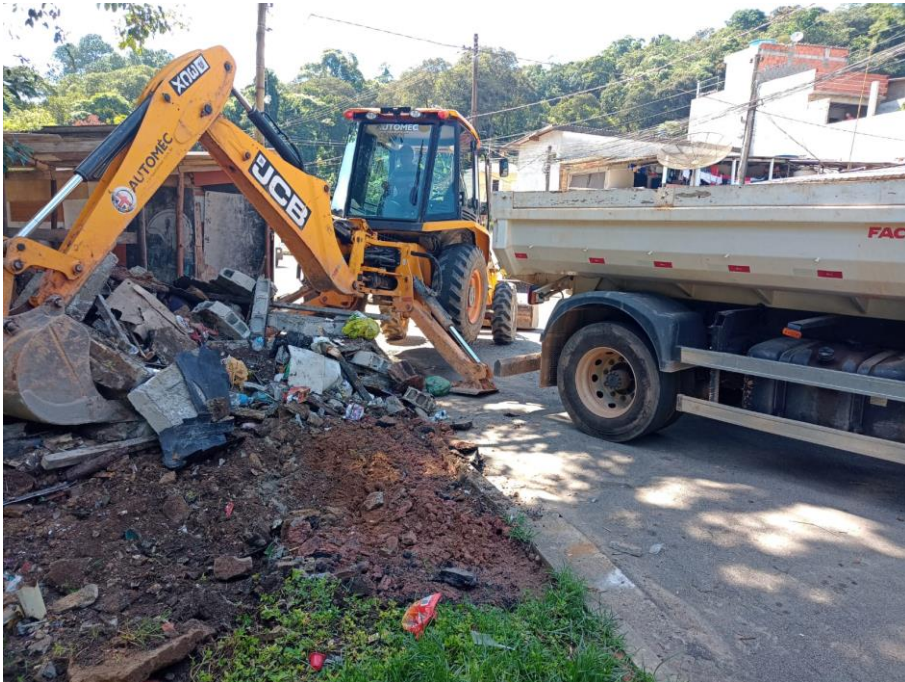
Foto 2: Desfazimentos no local.
