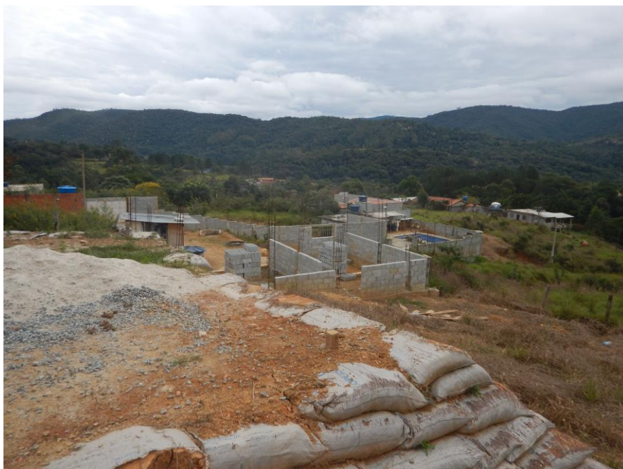
Foto 8: Vista do local da ação no município de Mairiporã.
