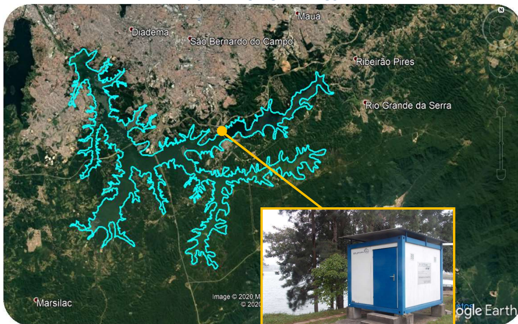
Estação Rio Grande
