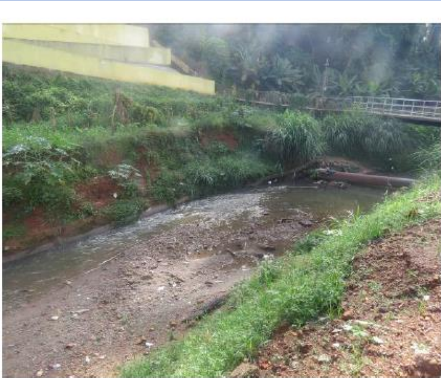
Foto 9.1.2.43: Córrego Santa Fé com canal
