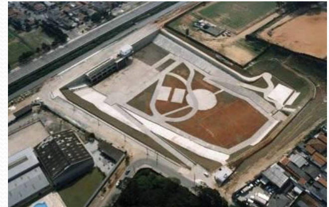
Reservatório AM-3 - Santo André
