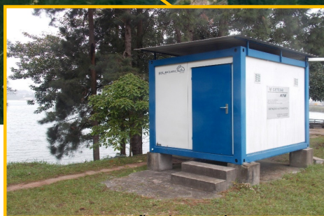
Estação Rio Grande
