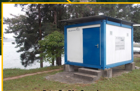
Estação Rio Grande
