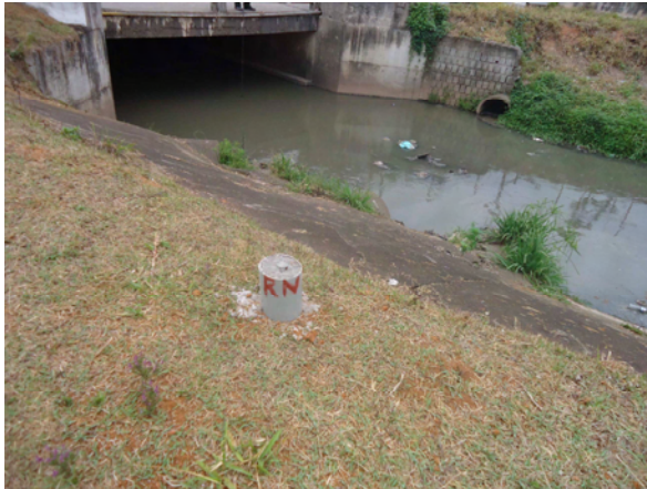
RN em tubo de PVC preenchido por cimento, parcialmente enterrado
