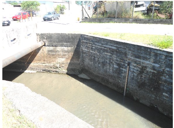
Régua chumbada em muro de córrego
