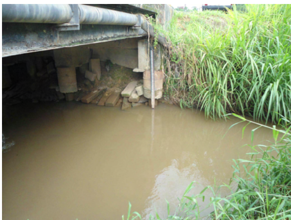
Régua chumbada em estrutura de apoio em ponte
