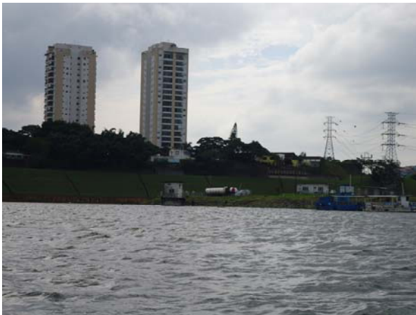
Ponto G06 localizado próximo à captação da SABESP
