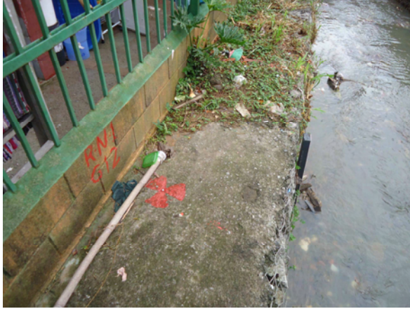
RN em guia de concreto
