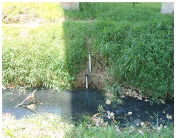
Réguas instaladas semi-interradas ao solo, na margem do corpo d'água
