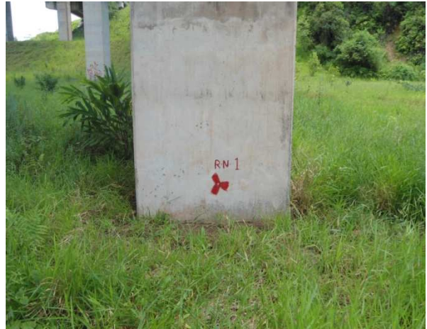
RN chumbada na base de sustentação de ponte
