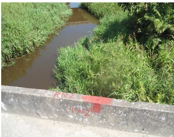
RN chumbada em estrutura de apoio em ponte
