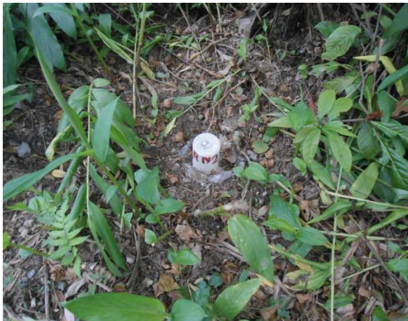
RN em tubo de PVC preenchido por cimento, parcialmente enterrado
