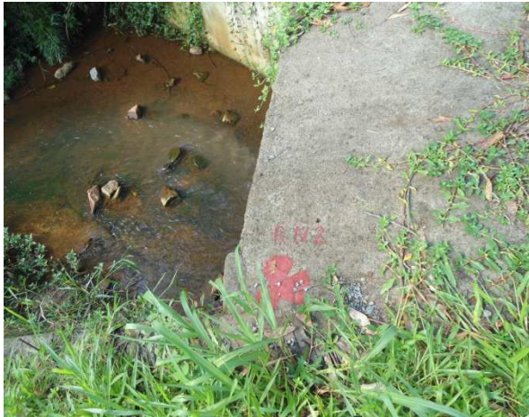
RN em guia de concreto
