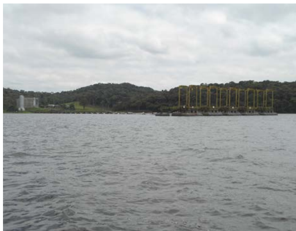
Ponto B16 próximo da estação de bombeamento do sistema de transposição Taquacetuba-Guarapiranga - SABESP
