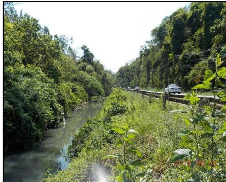
Vista do ribeirão dos Cristais paralelo a via marginal de Cajamar
