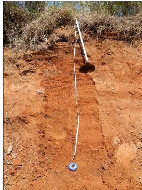
Perfil 1 em corte no acesso ao depósito de estéril. Nesta área ocorre Argissolo Vermelho Amarelo
