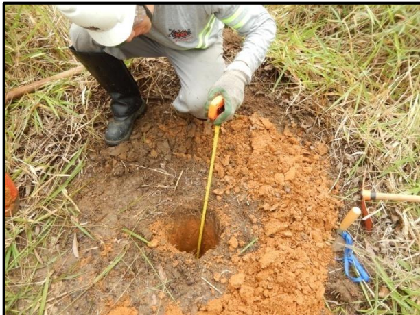
Medição realizada para verificação da profundidade atingida no furo 135
