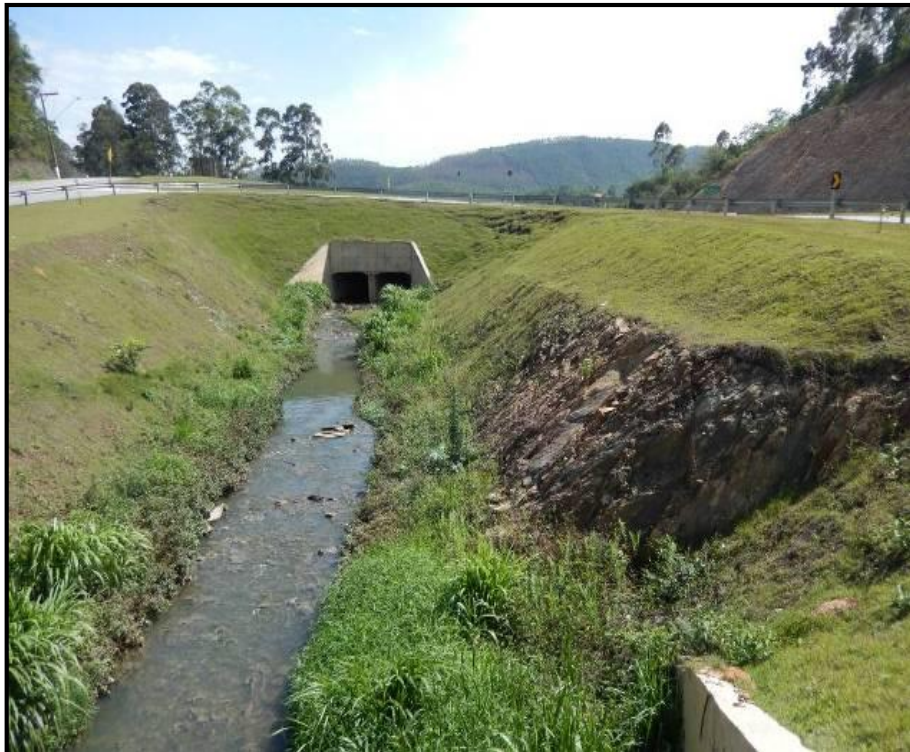
Vista do ribeirão das Lavras no trecho em que está canalizado
