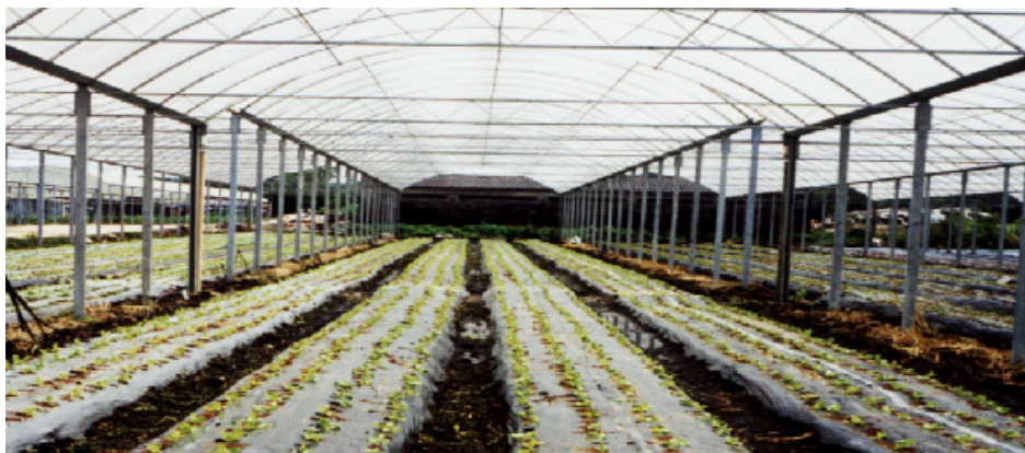
FIGURA 5 - Irrigação localizada subterrânea em ambiente protegido localizado em área de várzea do rio Tietê.
