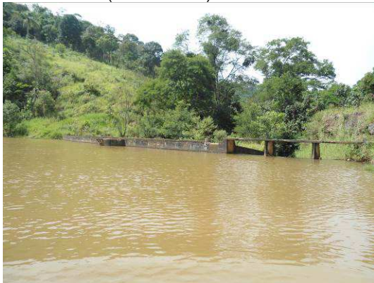
Fotografia 3 – Ponto de coleta no Res. Tanque Grande (TGDE00900) em 29.03.2012.
